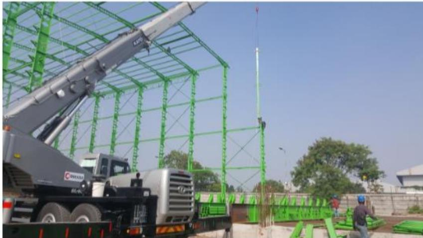
**Gambar 1. Erection Kolom Atas Observasi Nomor 21 As 20F Tanggal 26 Maret 2019**
