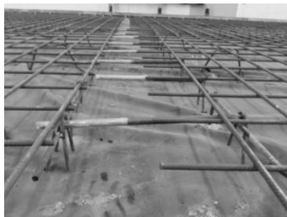
Gambar 4. Dowel Baskets pada Contraction Joint
