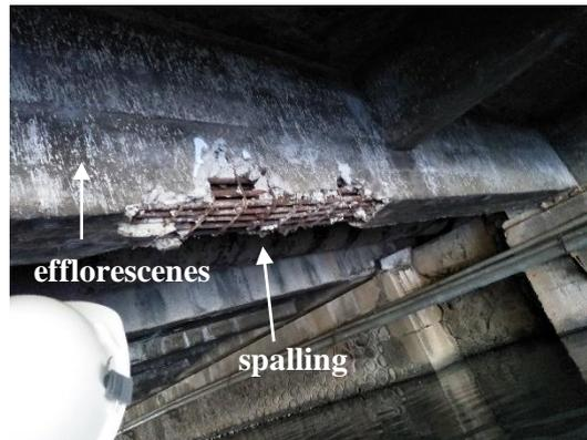
Gambar 2. Kerusakan pada Balok (*Efflorescences* dan *Spalling*)
