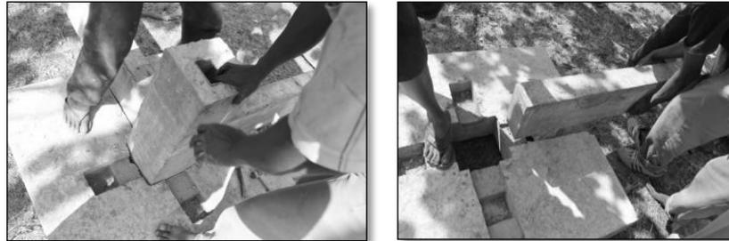
**Gambar 5. Pemasangan *Interlocking* Sistem 3**
