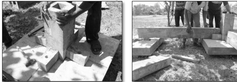
**Gambar 6. Pemasangan Sistem *Interlocking* Sistem 4**
