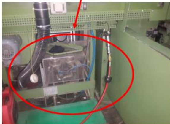
Gambar 3. Relokasi suction valve mesin focke 349
