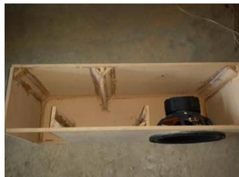
**Gambar 17. Tampak Atas Box Labirin sekat 3 sudut  $45^\circ$**
