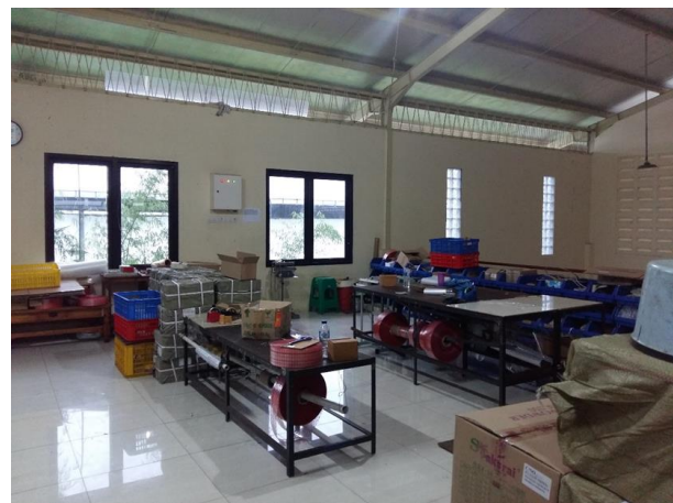
Gambar 5. Area Packing Setelah Perbaikan
