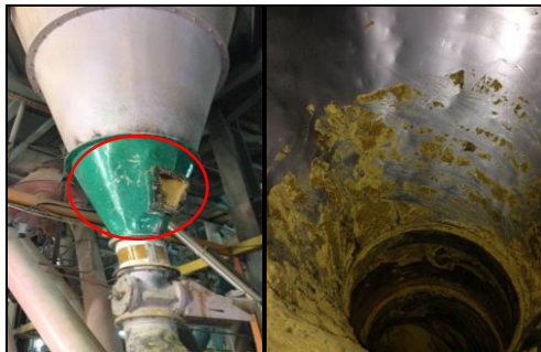
Gambar 3. Kondisi cyclone
