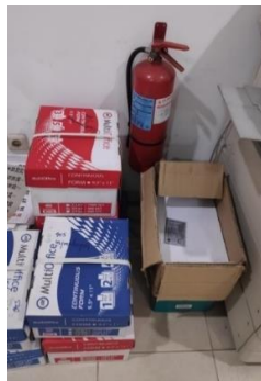
Gambar 3. Kondisi tempat penyimpanan APAR
