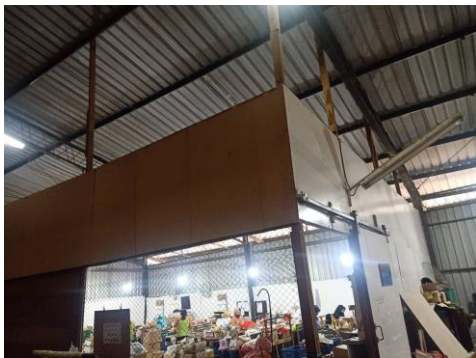
Gambar 4. Kondisi ruang GMT hardware
