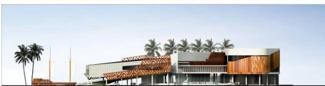
Gambar 2.24 Tampak bangunan dari arah utara. Sumber: penulis
