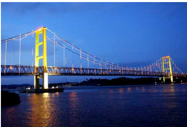
Gambar 1.4 Jembatan Barito. Sumber: Google Images
