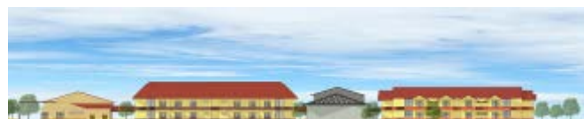
Gambar 2.18 Tampak bangunan dari arah selatan. Sumber: penulis
