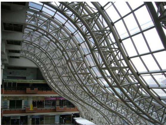
Gambar 2.14 Contoh Sistem struktur space frame. Sumber: penulis
