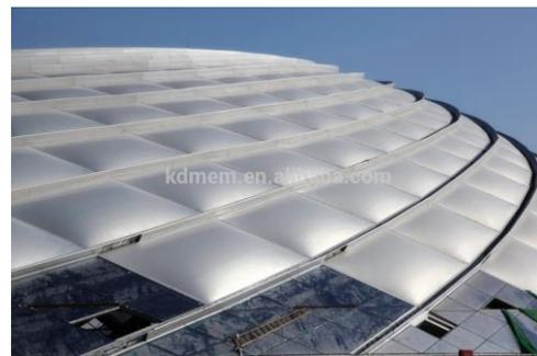
Gambar 2.24 Penutup Atap Membrane ETFE. Sumber: penulis
