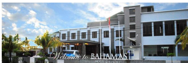
Gambar. 1.3 Tampak depan salah satu hotel yang sudah beroperasi : Bahamas Hotel Resort. Sumber: penulis.
