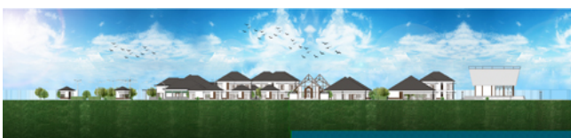
Gambar. 2.19. Tampak bangunan dari arah selatan.
