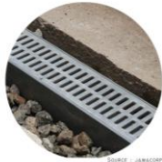
Gambar 2.28. Tampak sistem saluran tertutup
