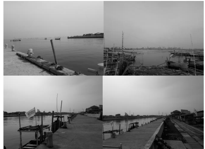
Gambar 1.3. Kondisi tapak eksisting
