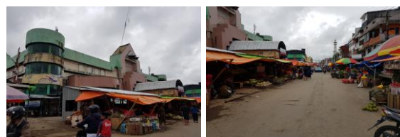
Gambar 1. 1. Eksisting Pasar Terong Makassar dan Jalan Terong saat ini
