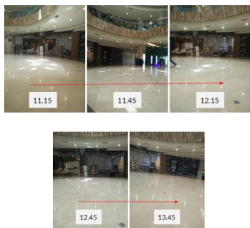
Gambar 4.3 Kebocoran yang terjadi pada atrium A (Sumber: dokumentasi pribadi)
