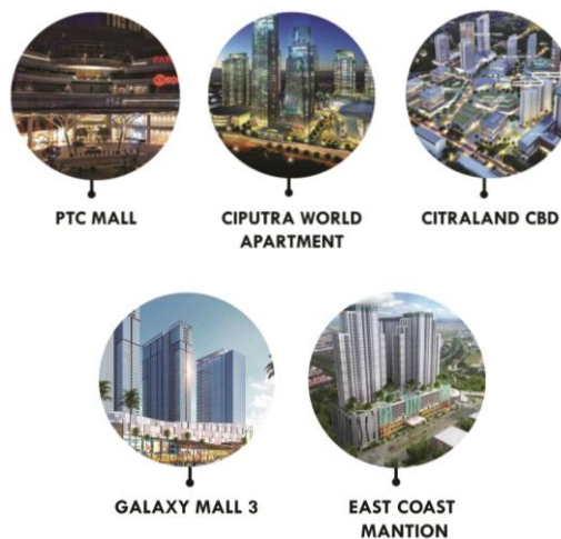
Gambar 1. 2. Pembangunan Gedung Bertingkat.
