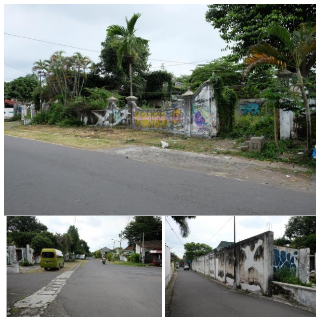
Gambar 1. 4. Lokasi tapak eksisting
