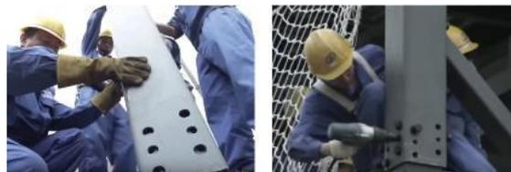
Gambar 2.13. Ilustrasi mekanisme bongkar pasang elemen struktur.
