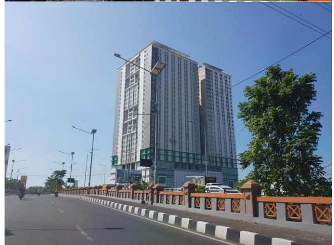
Gambar 1. 3. Lokasi tapak eksisting.
