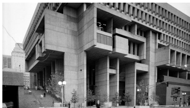
Gambar 2.12. Salah satu contoh penggunaan beton pracetak Sumber: Dinas Pekerjaan Umum
