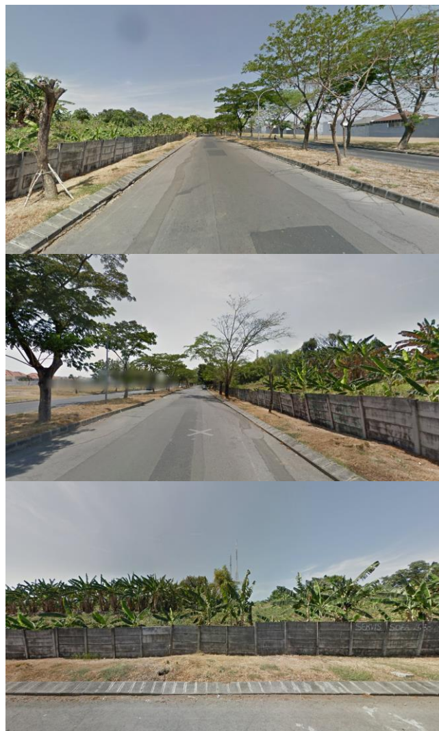
Gambar 1. 2. Lokasi tapak eksisting.
