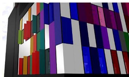
Gambar 2.24. Shading yang menghalangi cahaya datang dari sisi barat
