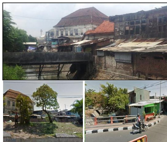
Gambar 1.4. Lokasi tapak eksisting.
