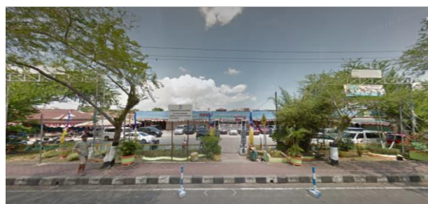
Gambar 1. 4. Lokasi tapak eksisting.
