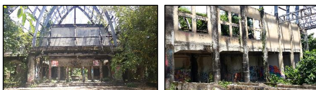
Gambar 1.4. Lokasi tapak eksisting.
