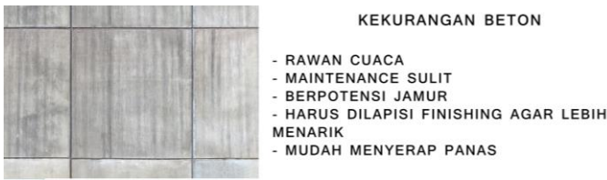
Gambar 2.14. Kekurangan material beton
