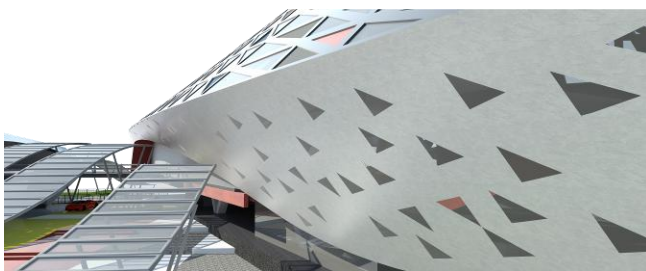
Gambar 2. 8. Material eksterior bangunan menggunakan material Aluminium Composite Panel dengan bentuk bukaan segitiga.
