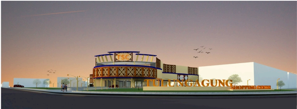
Gambar. 1. Perspektif bangunan ( human-eye view ) Pusat Perbelanjaan Modern di Tulungagung
