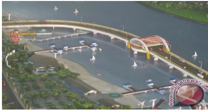
Gambar. 1.2. Jembatan THP kenjeran Sumber : antaranews.com
