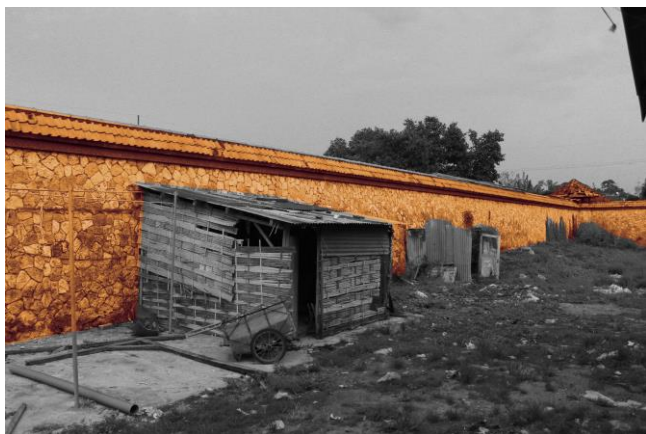
Gambar 1. 6. Kondisi di sisi dalam dinding Penjara Koblen : penuh bangunan non-permanen tanpa fungsi yang jelas Sumber : dokumentasi pribadi
