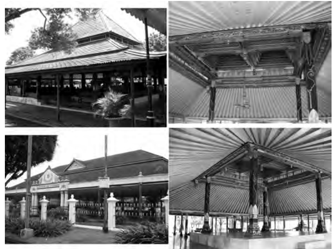
Gambar. 2.15. Pendapa di kompleks kraton – bagian interiornya
