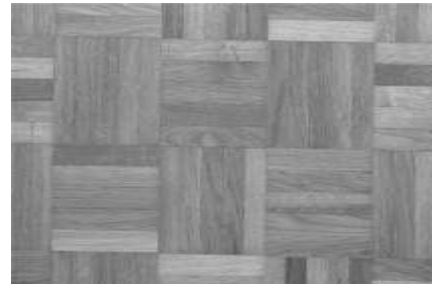
Gambar 2.17 Parket Kayu yang Digunakan Pada Lantai
