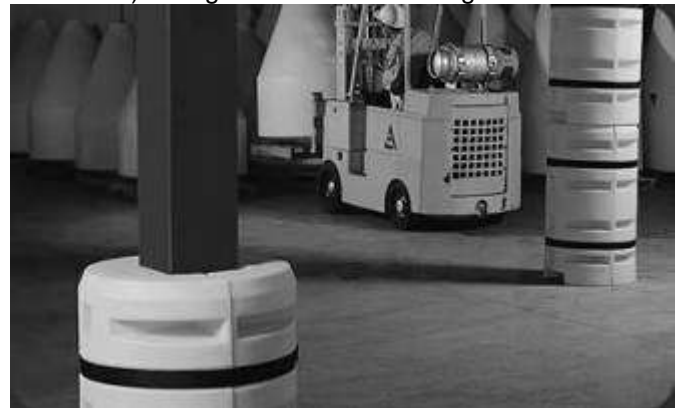
Gambar 2. 8 Kolom yang Diberi Pelindung
