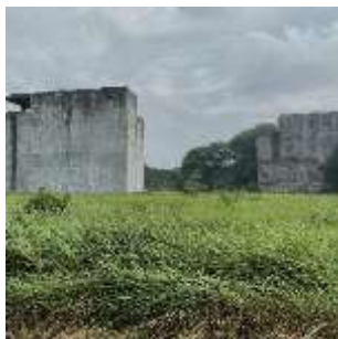
Gambar 1.3. Kondisi tapak (Sumber: Foto Pribadi)
