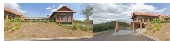
Gambar 1.3. Lokasi tapak eksisting.
