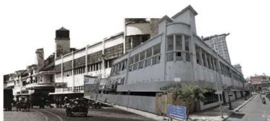
Gambar 2. 3. Bangunan Savelkoul (Sumber: Olahan pribadi)
