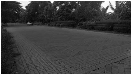
Gambar 2. 6. Jalan satu arah
