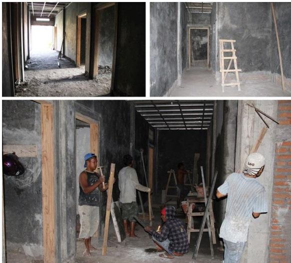
Gambar 2. Pembangunan hotel Gowin
