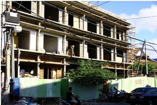
Gambar 1. Pembangunan hotel Gowin
