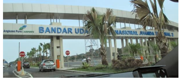
Sumber: Zul (2014, par. 4) Gambar 32. Gerbang masuk kendaraan ke Terminal 2 Bandara Juanda
