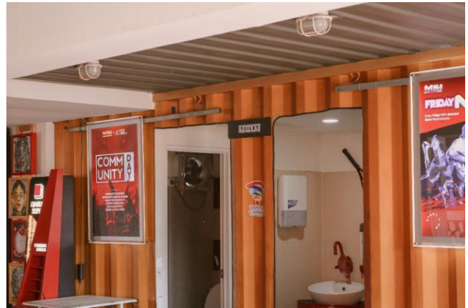
Gambar 18. Dinding dan plafon yang diekspos
