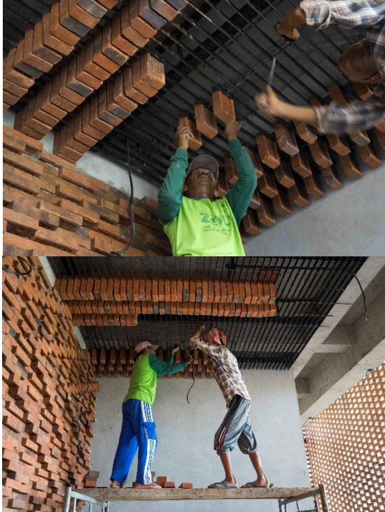
Gambar 2. Proses pemasangan bata pada plafon [18]
