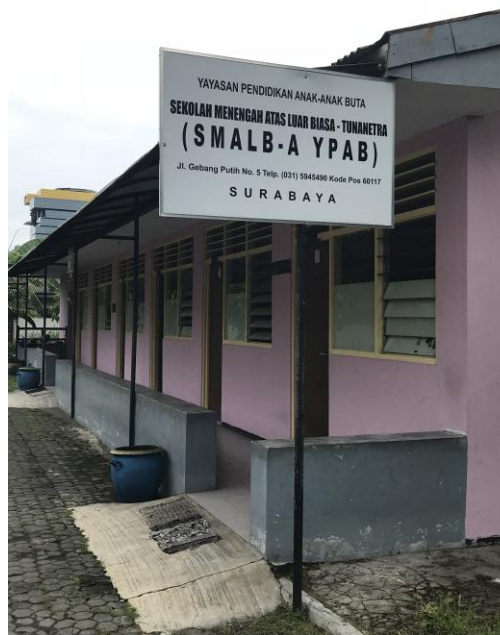
Gambar 2. Tampak depan bangunan objek 2
