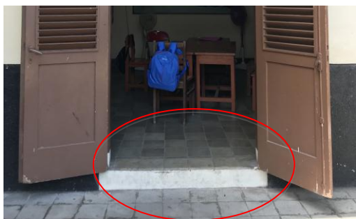
Gambar 8. Adanya perbedaan ketinggian yang tidak sesuai pada objek 1
