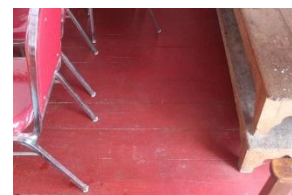
Gambar. 8. Lantai area balkon bangunan GPIB Immanuel Probolinggo
