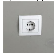
Gambar 8. Sistem Mekanikal Elektrikal Lenmarc Mall Sumber: Dokumentasi Pribadi, 2017
