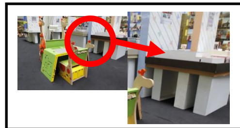
Gambar 2. Penggunaan panggung berbahan triplek yang tidak memiliki konstruksi yang kuat sebagai media peletakkan maket yang merupakan pemaksaan perabot
