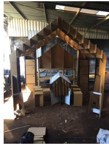
Gambar 4.30. Booth Keseluruhan Pada Percobaan Ke 2, Permasalahan Atap Berhasil Diatasi
