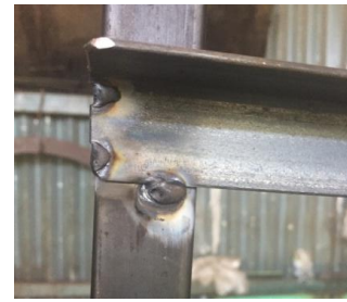
Gambar 4.23. Sambungan Besi Dengan Menggunakan Las
