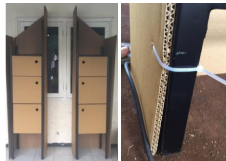
Gambar 4.25. Pillar Storage Konstruksi Sambungannya Menggunakan Cable Ties
