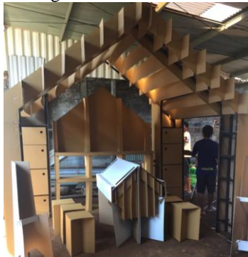
Gambar 4.28. Konstruksi Atap Cardboard
